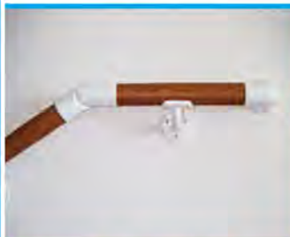
30 cm über die letzte Stufe geführt, mit Abschlussbogen
