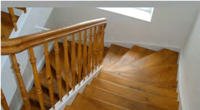
... Nur mit Wandhandlauf ist diese Treppe sicher begehbar
